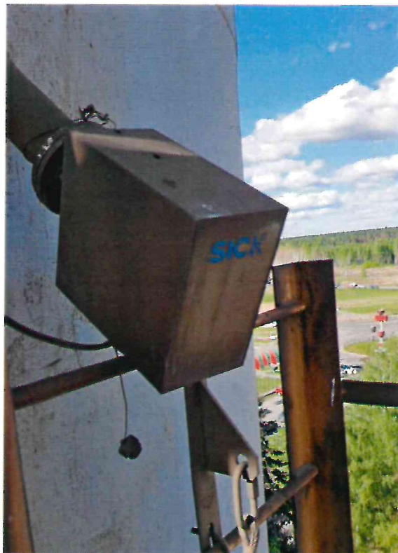
Рисунок 1.3 – Фотография датчиков измерителя скорости газового потока. Система автоматизированная контроля и учета выбросов № СЭ.20322.АСК.002.УХЛ1 от дымовой трубы ДСП-2 ист. выбросов № 0002. ОАО «БМЗ» № СЭ.20322.АСК.002.УХЛ1
