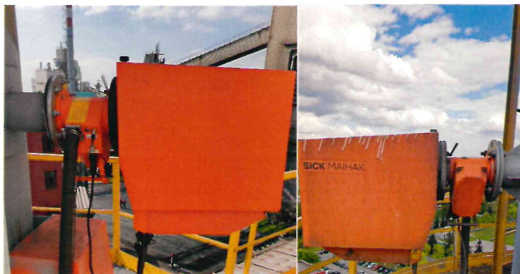
Рисунок 1.4 – Фотографии датчиков газоанализатора беспробоотборного GM31 и GM35. Система автоматизированная контроля и учета выбросов № СЭ.20322.АСК.002.УХЛ1 от дымовой трубы ДСП-2 ист. выбросов № 0002. ОАО «БМЗ» № СЭ.20322.АСК.002.УХЛ1
