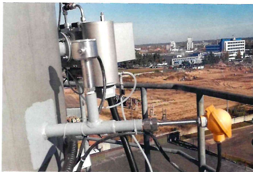
Рисунок 1.4 – Фотографии общего вида подсистемы измерения параметров дымового газа АСКВ с преобразователем температуры CTR-6, преобразователем давления РС-28, измерителем скорости дымового газа FLOWSIC100, исполнение М
