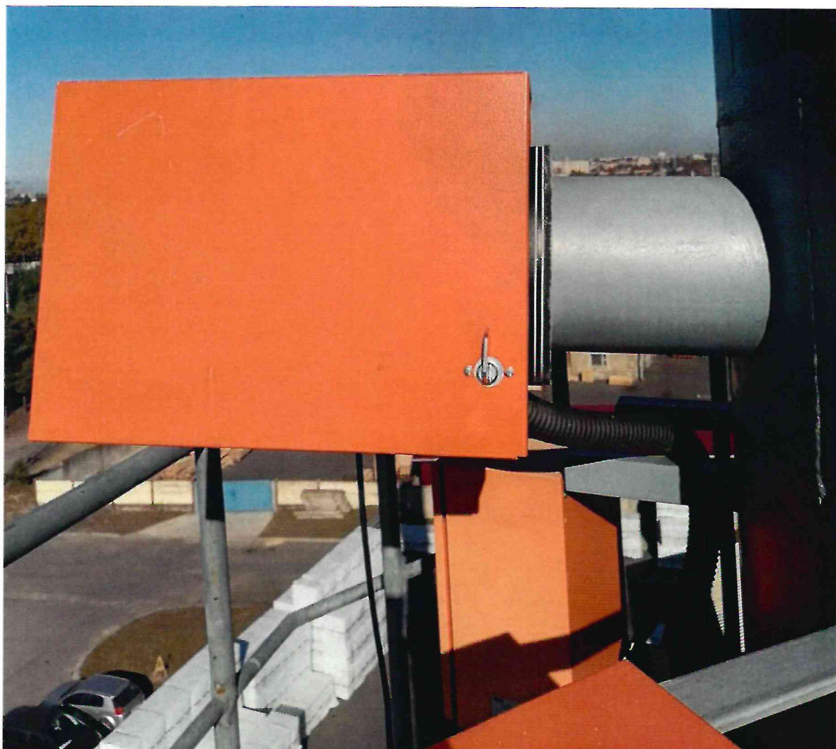
Рисунок 1.5 – Фотография общего вида подсистемы измерения концентрации твердых частиц в дымовых газах АСКВ с анализатором пыли DUSHUNTER SB100
