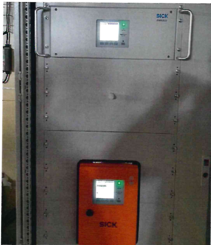
Рисунок 1.3 – Фотографии общего вида подсистемы измерения концентраций газов с газоанализатором GMS 810 с модулями и анализатором кислорода ТДК-3М
