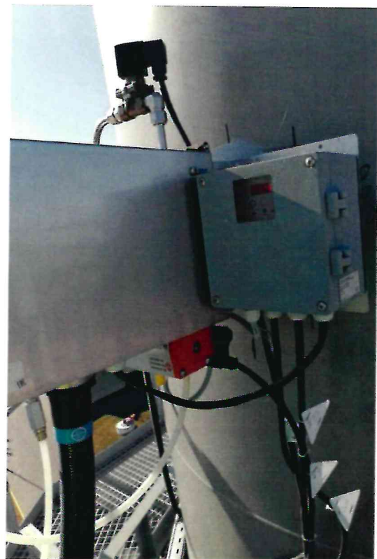
Рисунок 1.3 – Фотографии общего вида подсистемы измерения концентраций газов с газоанализатором GMS 810 с модулями и анализатором кислорода ТДК-3М
