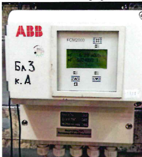
Рисунок 1 – Фотография расходомера массового FCM2000
