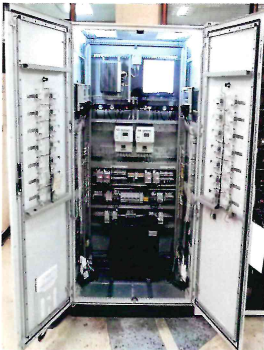
Рисунок 6 – Фотография шкафа серверного
