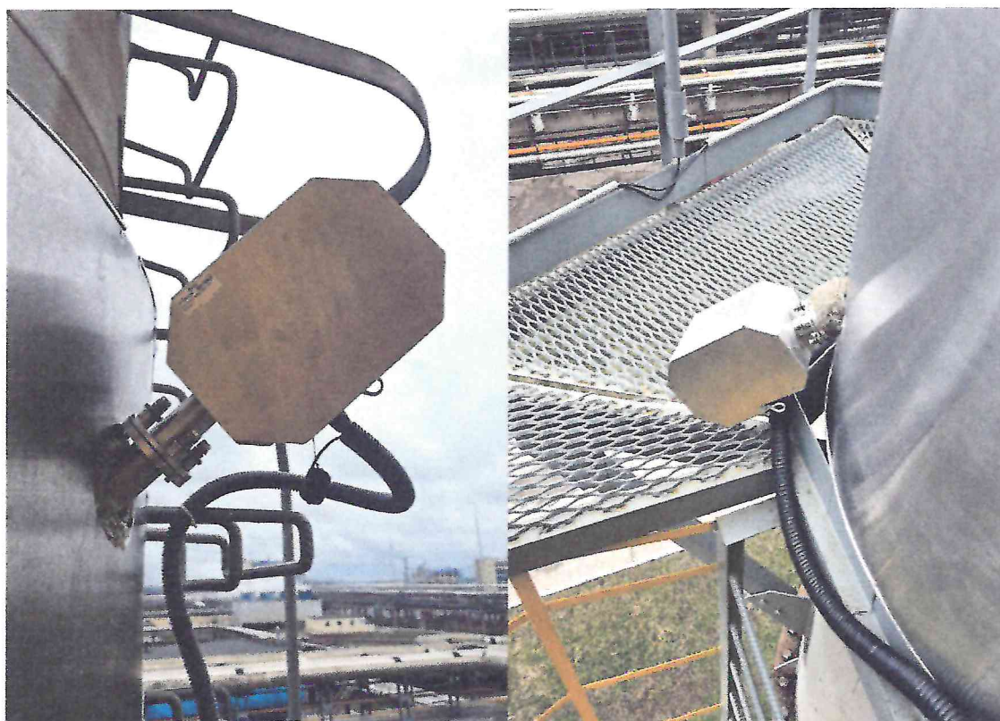
Рисунок 1.3 – Фотография датчиков измерителя скорости газового потока. Система автоматизированная контроля выбросов № ECS-22.426 -01
