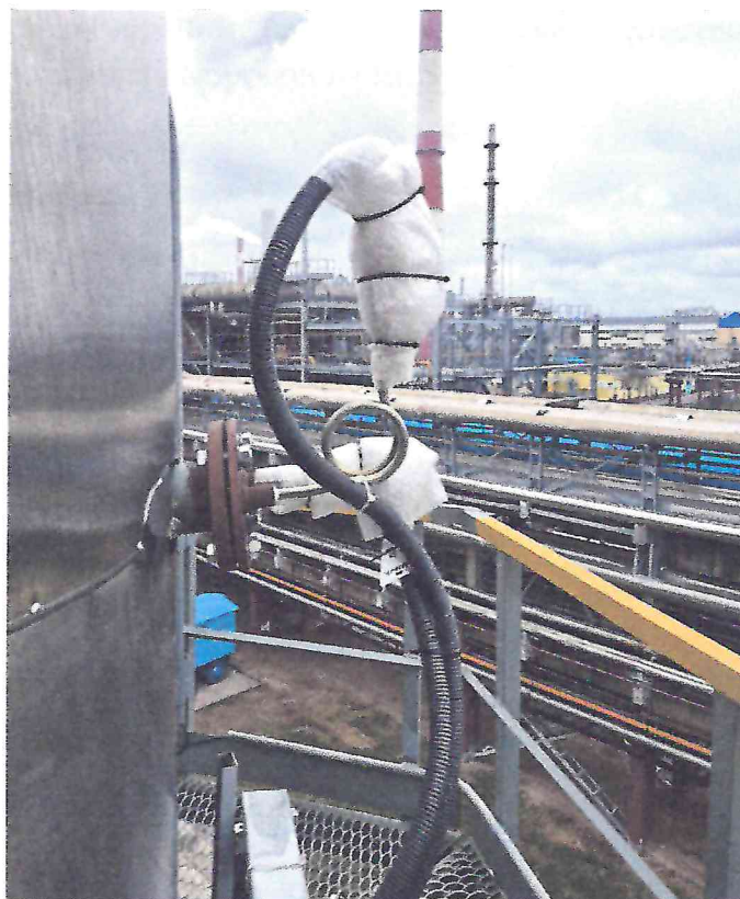
Рисунок 1.6 – Фотография преобразователя давления и термопреобразователя. Система автоматизированная контроля выбросов № ECS-22.426-01
