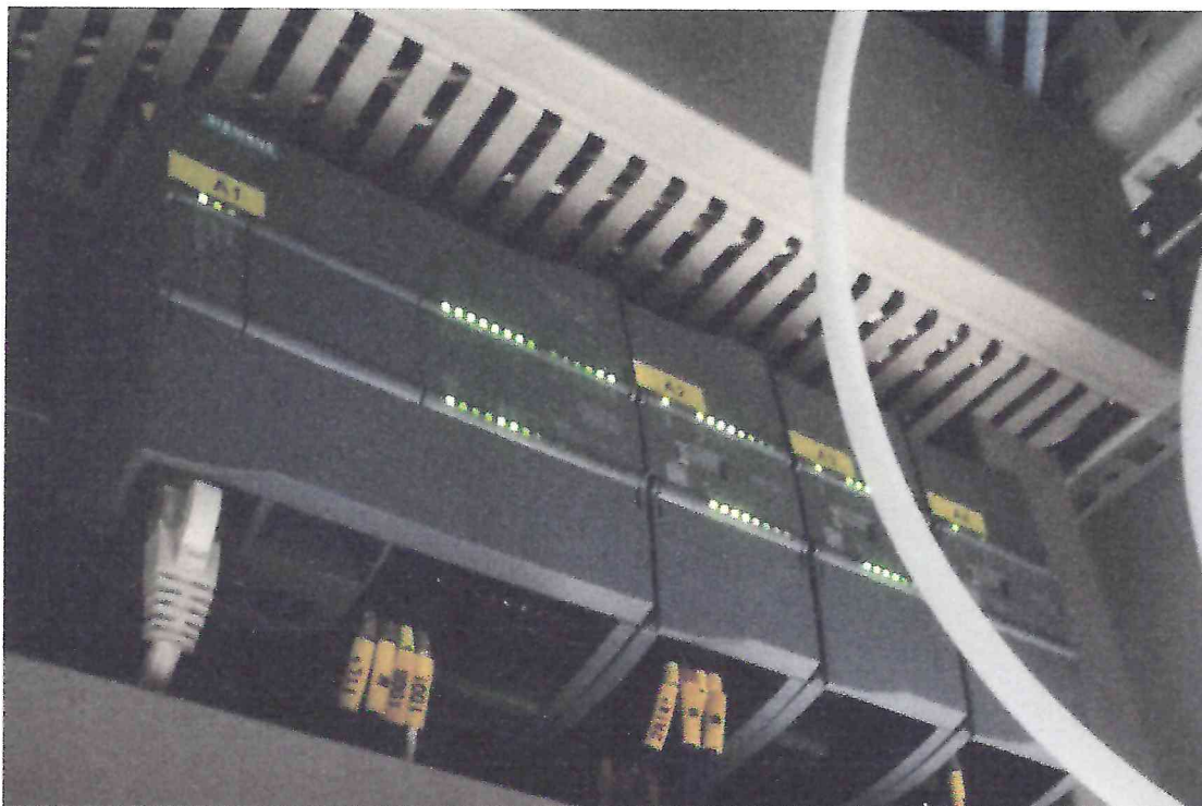
Рисунок 1.4 – Фотография модулей контроллера измерительного. Система автоматизированная контроля выбросов № ECS-22.426-01
