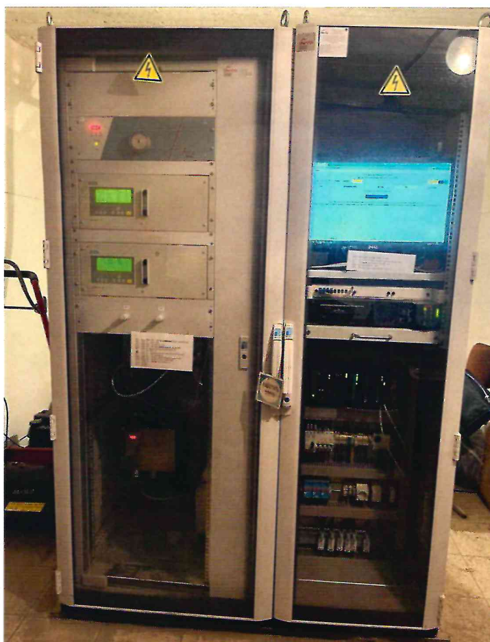
Рисунок 1.3 – Фотография общего вида компонентов из состава АСКВ (шкаф газового анализа, изображение носит иллюстративный характер)
