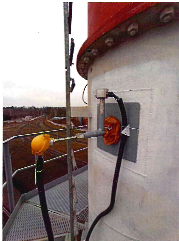
б) преобразователь температуры CTR-6 и преобразователь давления PC-28
