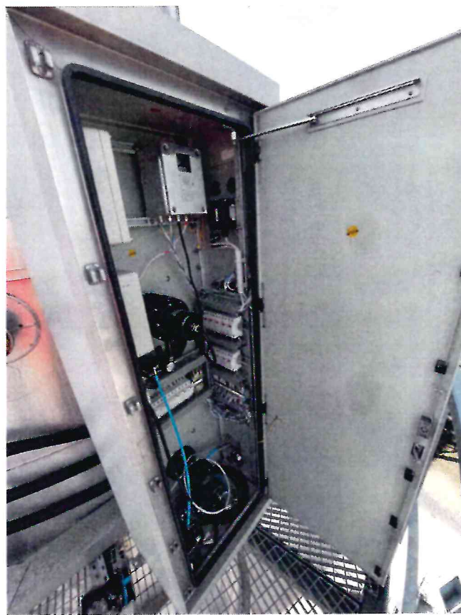
Рисунок 1.6 – Фотографии измерителя скорости газовоздушных потоков инфракрасного ВСЕМ 5100 в шкафу Intertec
