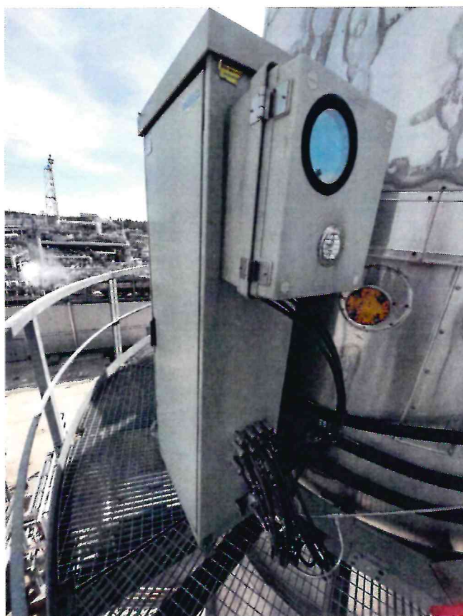
Рисунок 1.6 – Фотографии измерителя скорости газовоздушных потоков инфракрасного ВСЕМ 5100 в шкафу Intertec
