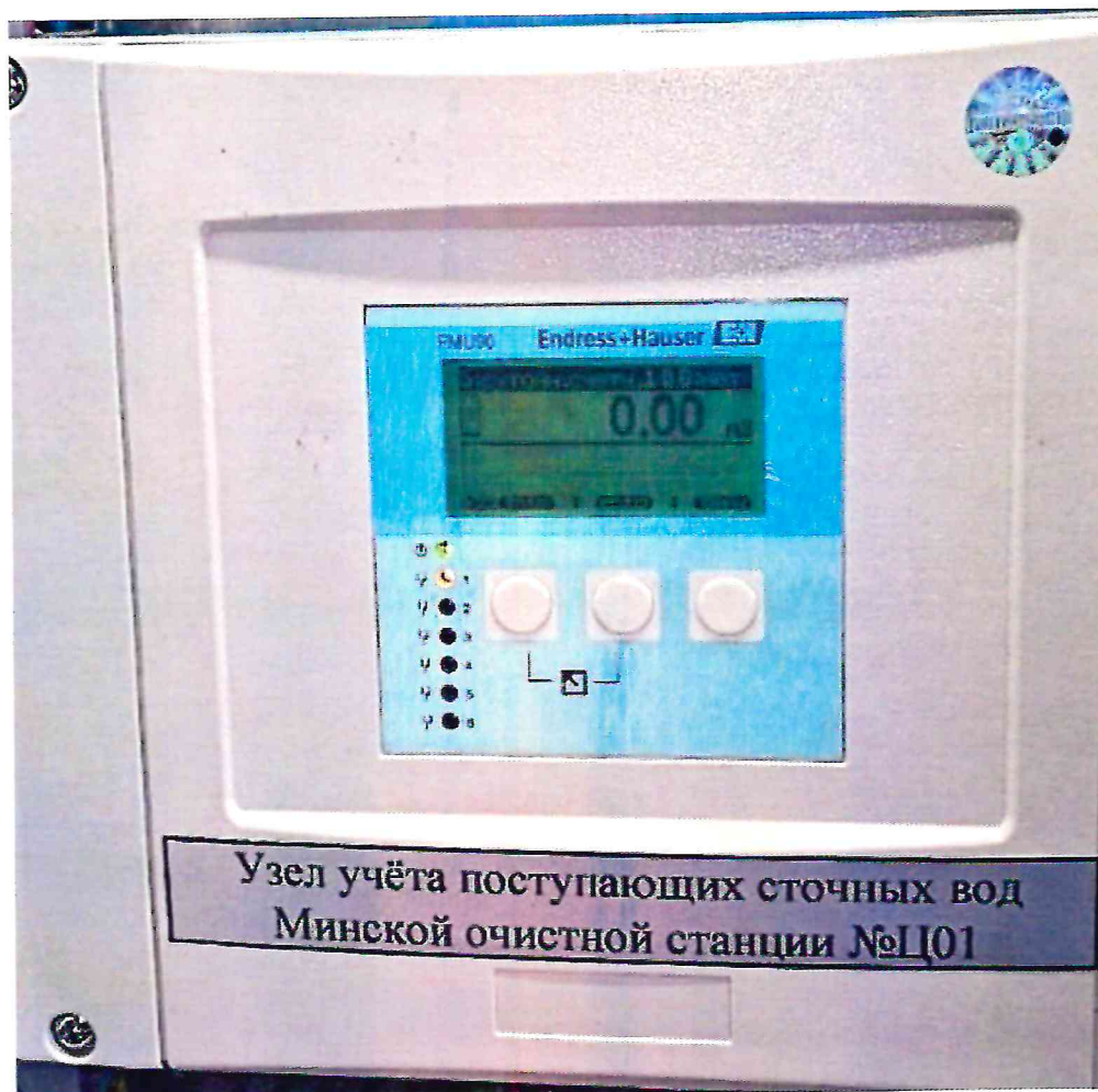
Рисунок 1.8 – Фотография маркировки системы учета поступающих сточных вод цеха очистных сооружений Минской очистной станции № Ц01
