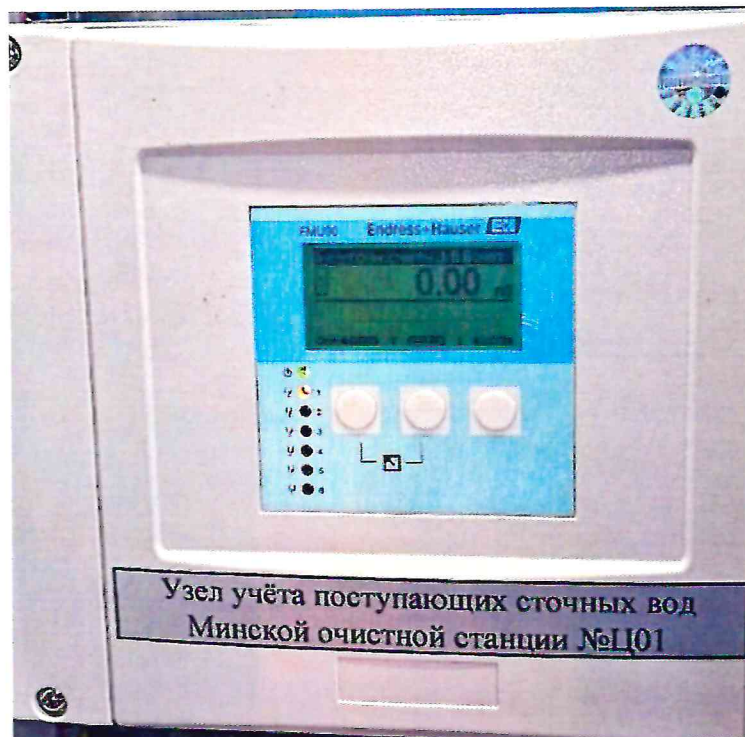
Рисунок 1.1 – Фотография общего вида вторичного преобразователя FMU90-R21CA113BA2A входящего в состав узла учета поступающих сточных вод Минской очистной станции № Ц01
