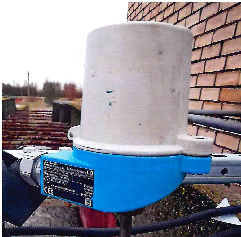
Рисунок 1.5 – Фотография общего вида термопреобразователя сопротивления TR10-GOD3BGSXF3000 входящего в состав узла учета поступающих сточных вод Минской очистной станции № Ц01
