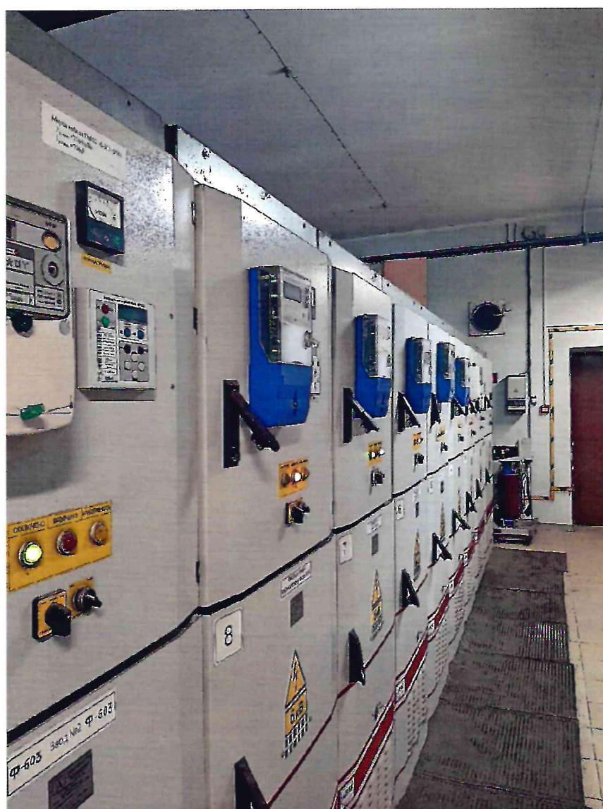
Рисунок 1.3 – Фотографии счётчиков, входящих в состав измерительных каналов АСКУЭ (изображения носят иллюстративный характер)
