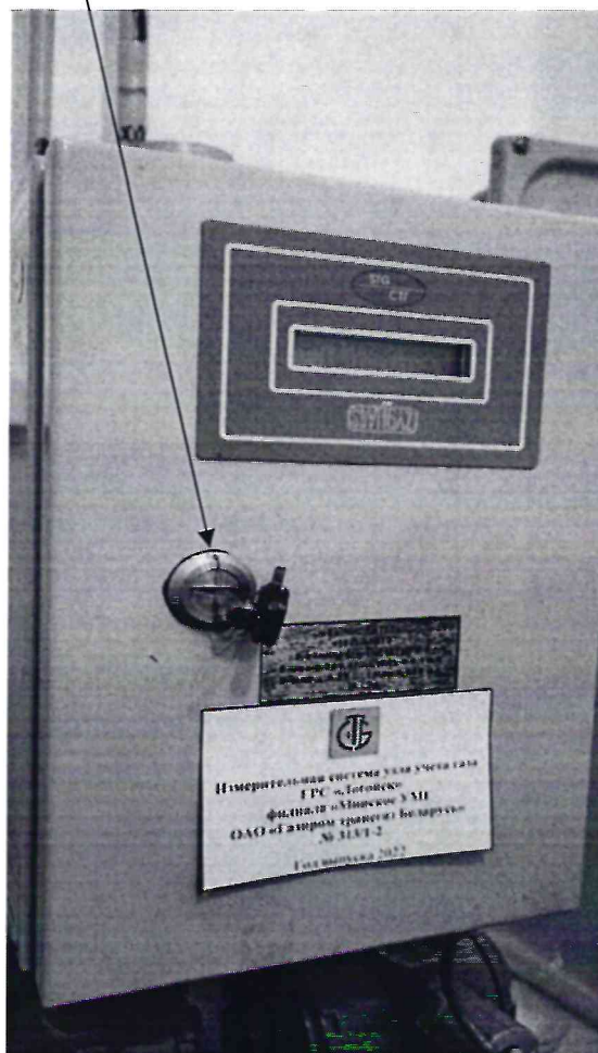
Рисунок 3.1 – Схема пломбировки от несанкционированного доступа
