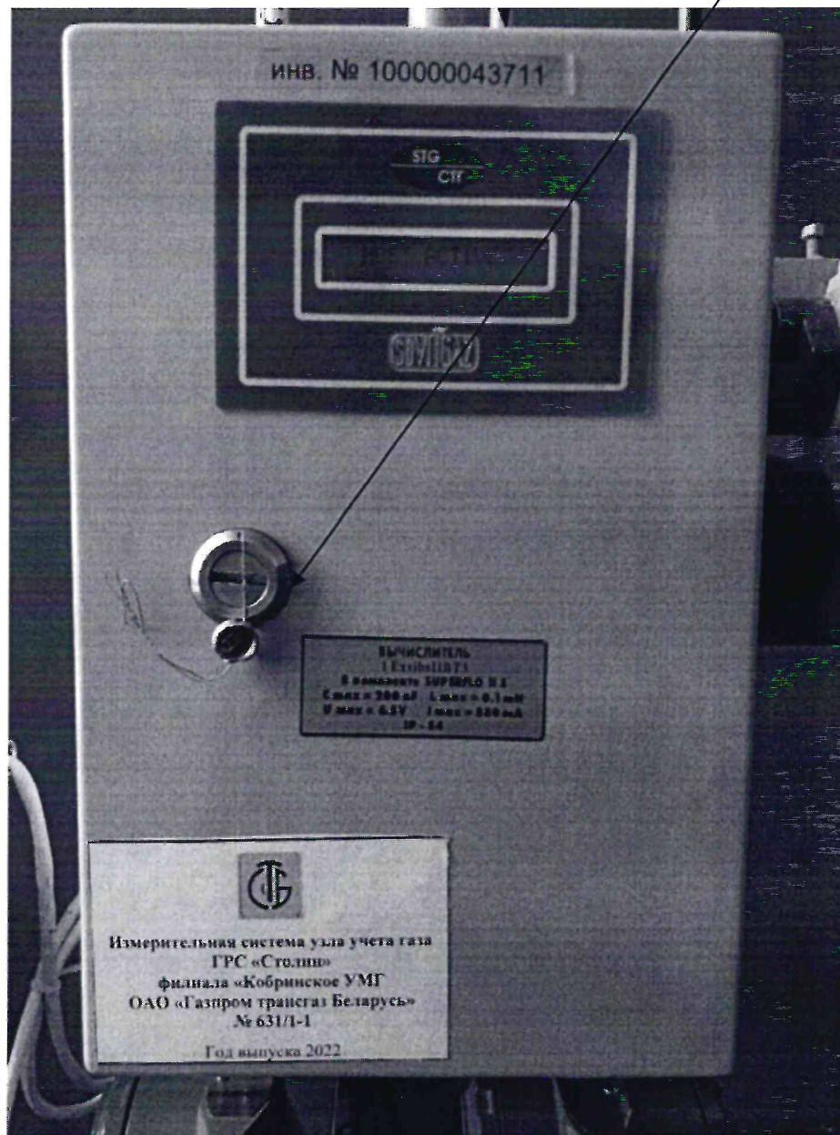
Рисунок 3.1 – Схема пломбировки от несанкционированного доступа
