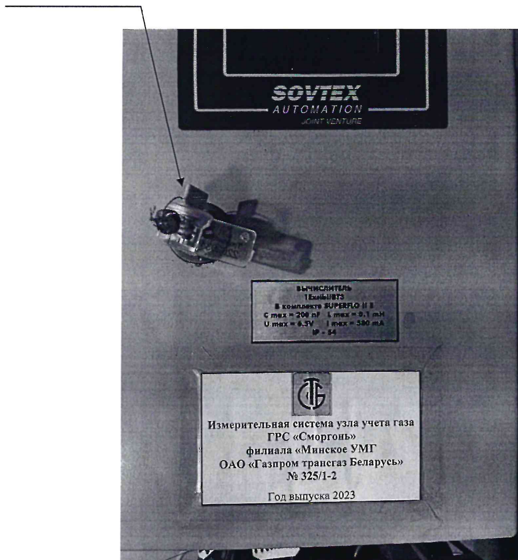
Рисунок 3.1 – Схема пломбировки от несанкционированного доступа
