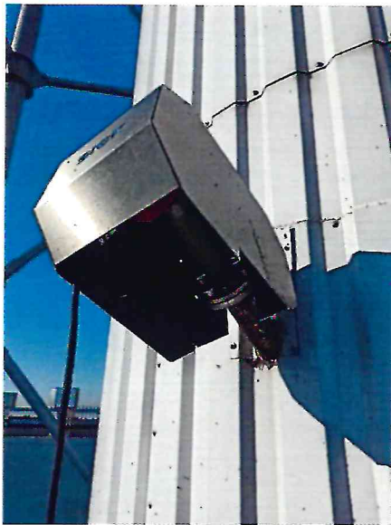
а) датчики измерителя скорости ультразвукового FLOWSIC100
