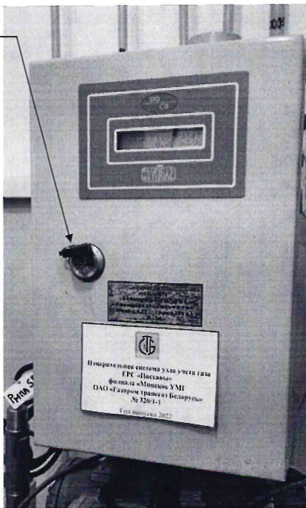
Рисунок 3.1 – Схема пломбировки от несанкционированного доступа
