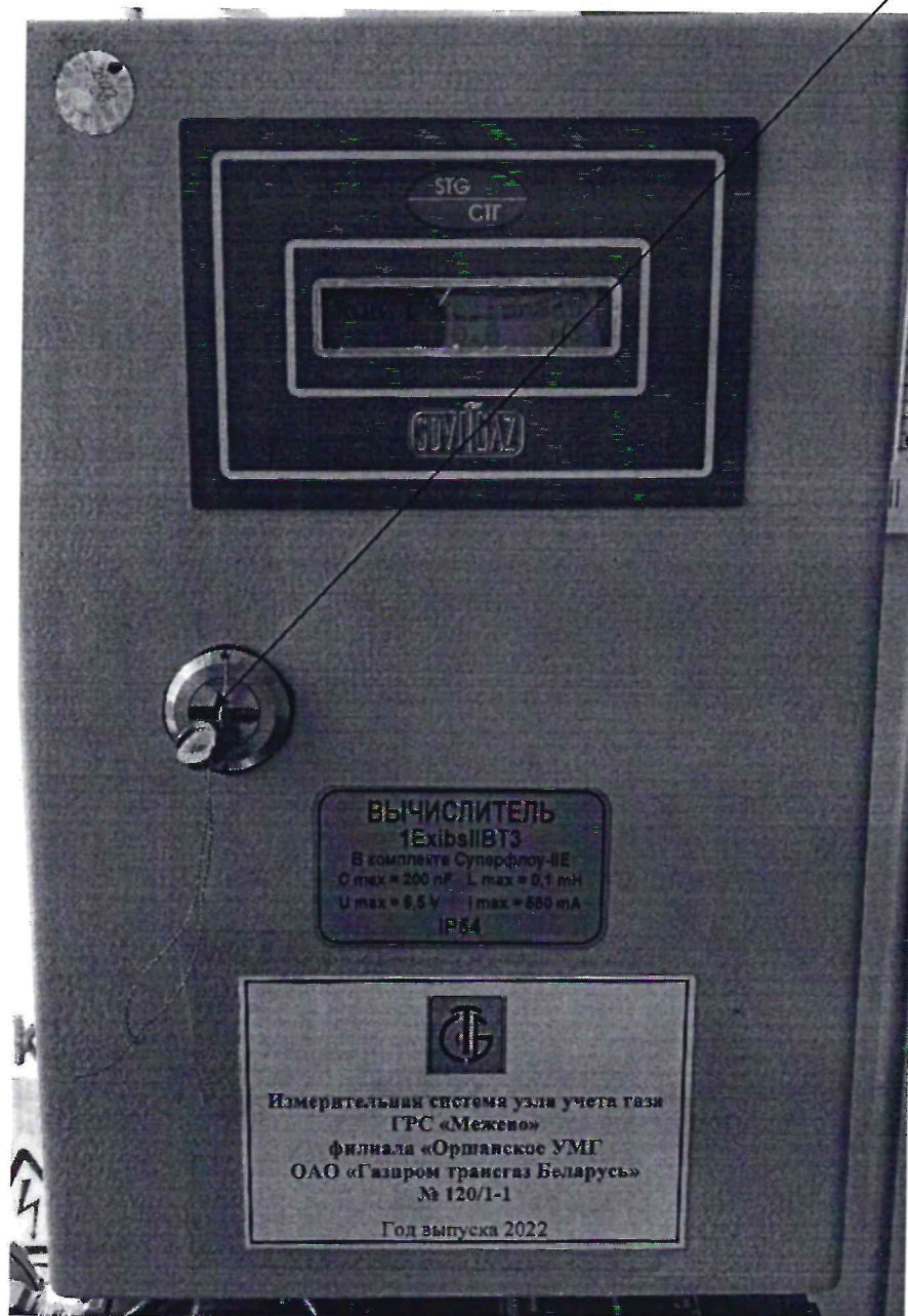
Рисунок 3.1 – Схема пломбировки от несанкционированного доступа
