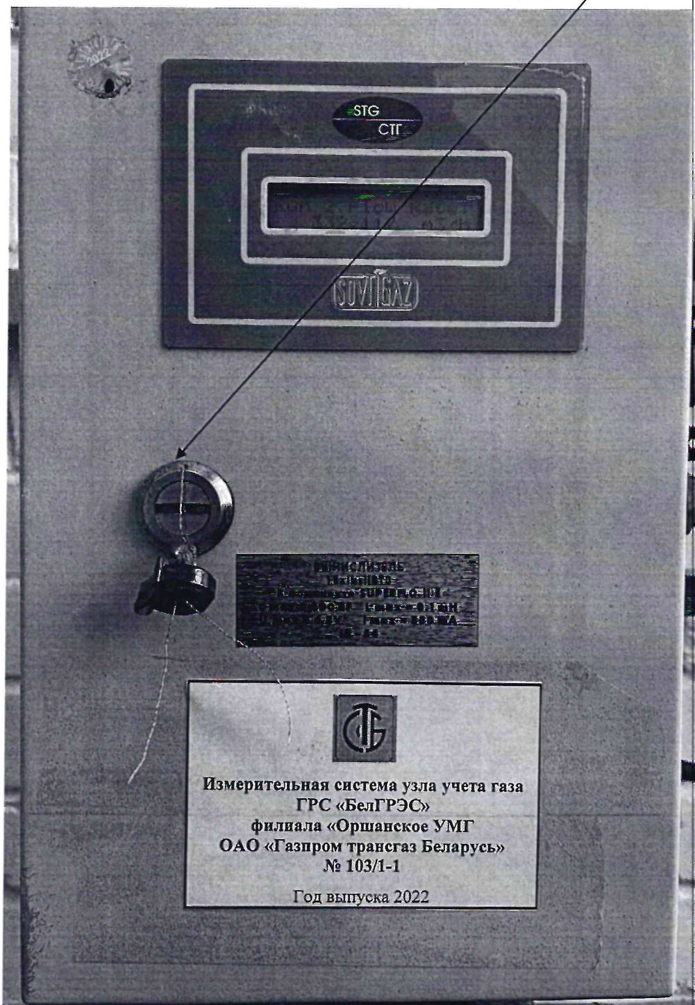
Рисунок 3.1 – Схема пломбировки от несанкционированного доступа
