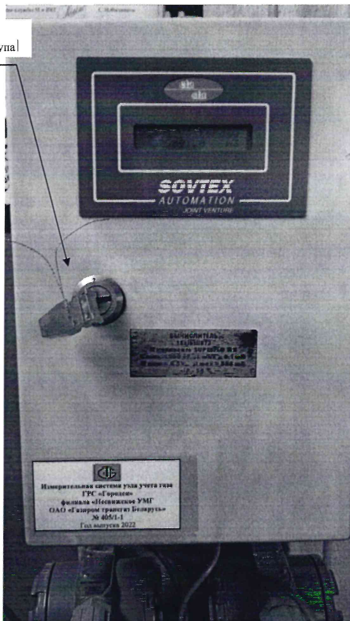
Рисунок 3.1 – Схема пломбировки от несанкционированного доступа
