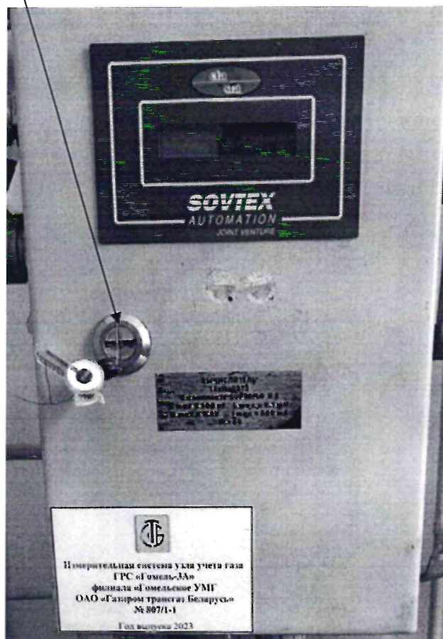
Рисунок 3.1 – Схема пломбировки от несанкционированного доступа
