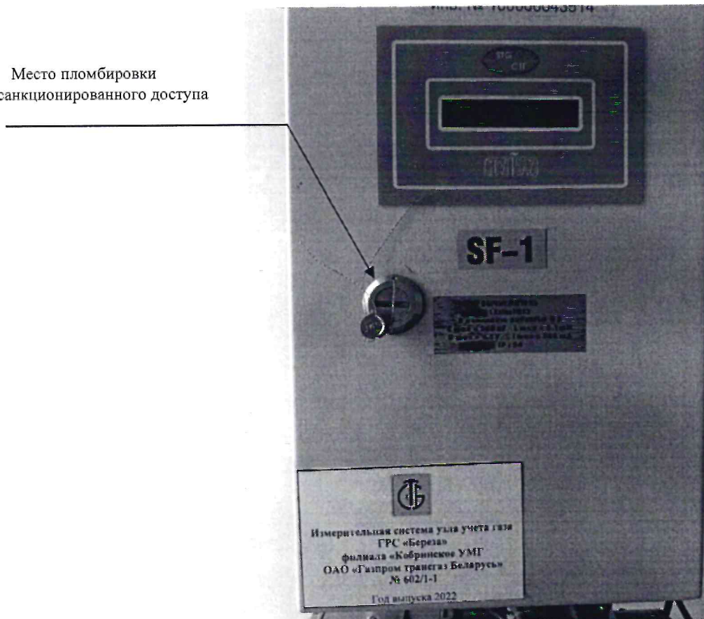
Рисунок 3.1 – Схема пломбировки от несанкционированного доступа
