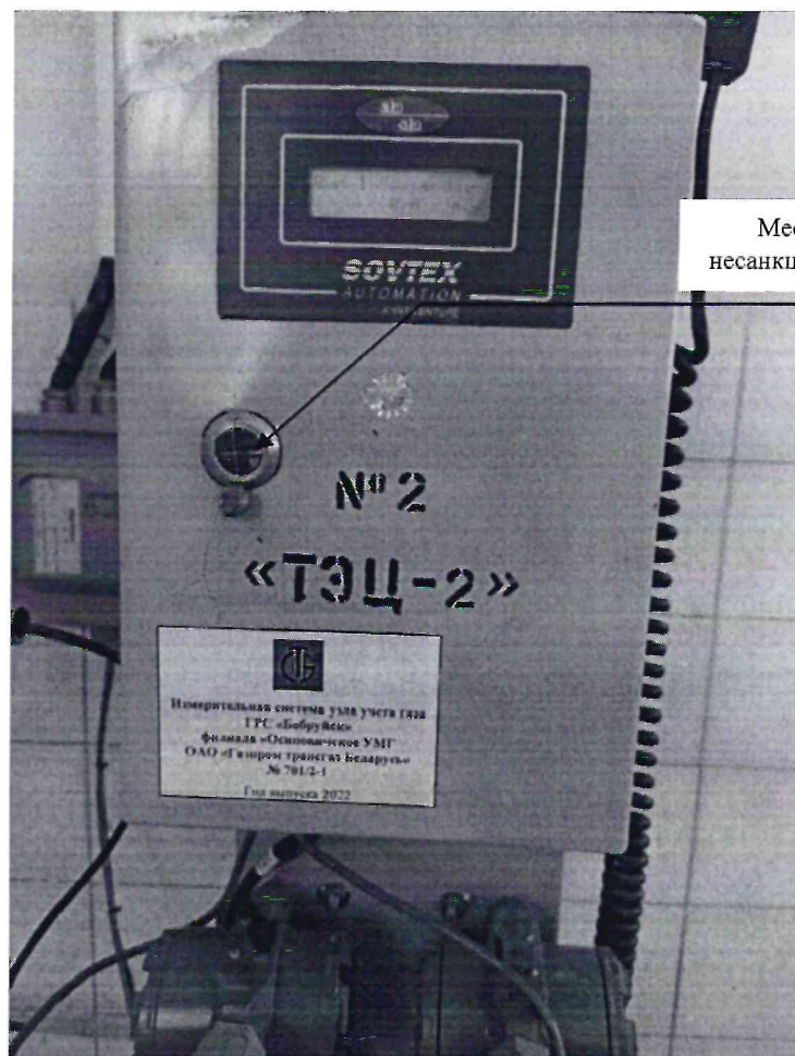
Рисунок 3.1 – Схема пломбировки от несанкционированного доступа
