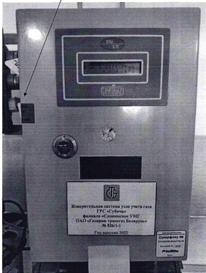
Рисунок 3.1 – Схема пломбировки от несанкционированного доступа
