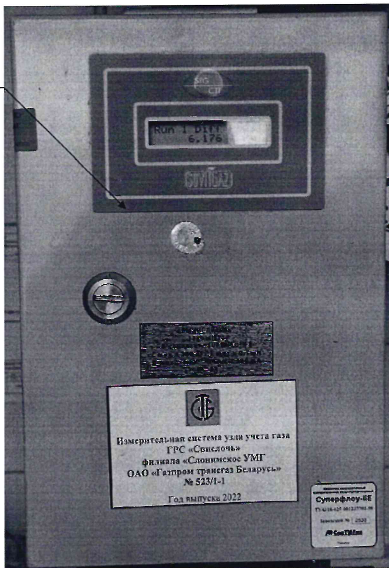
Рисунок 3.1 – Схема пломбировки от несанкционированного доступа
