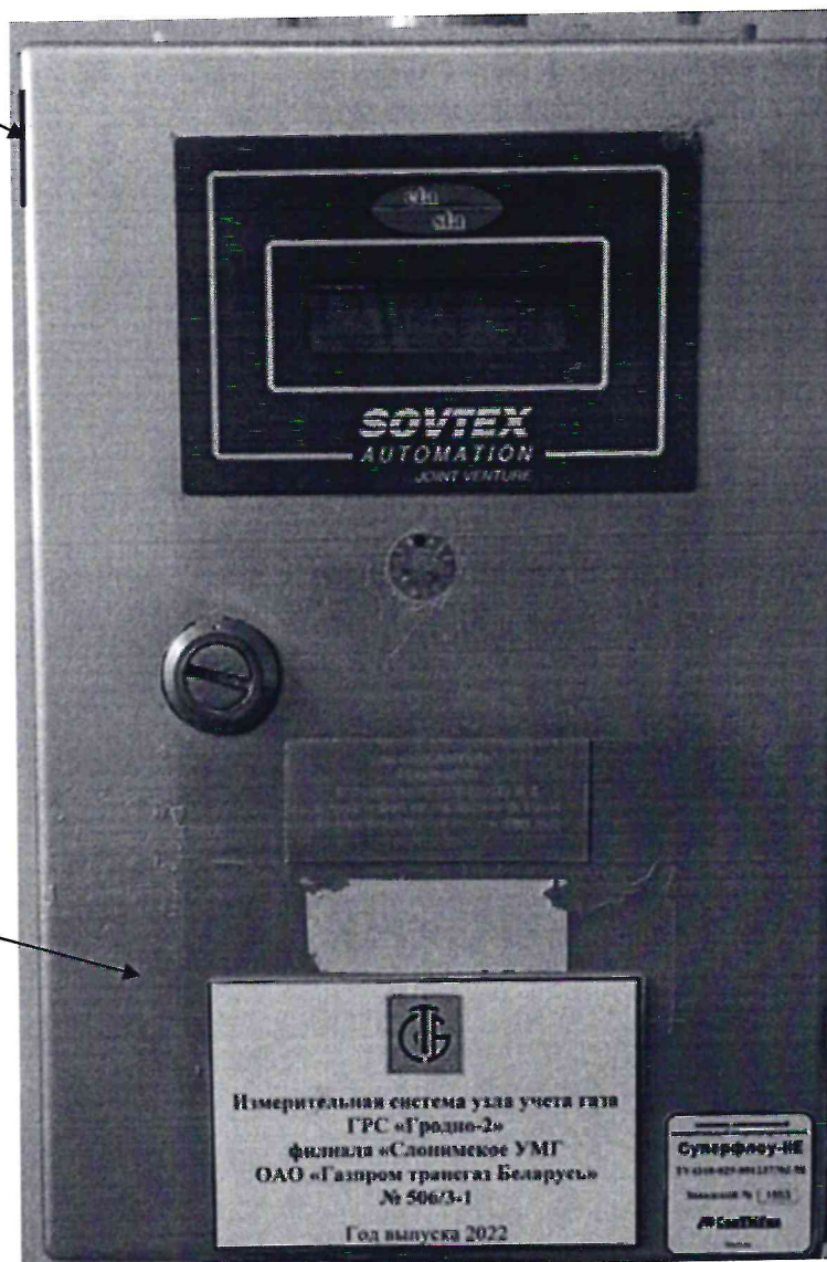
Рисунок 3.1 – Схема пломбировки от несанкционированного доступа
