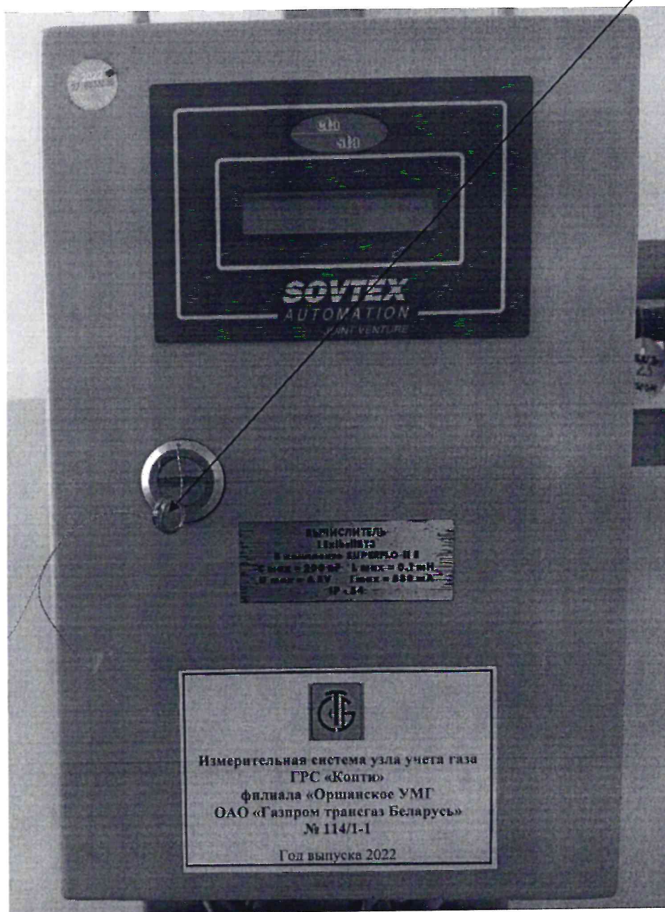
Рисунок 3.1 – Схема пломбировки от несанкционированного доступа
