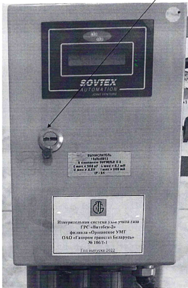
Рисунок 3.1 – Схема пломбировки от несанкционированного доступа
