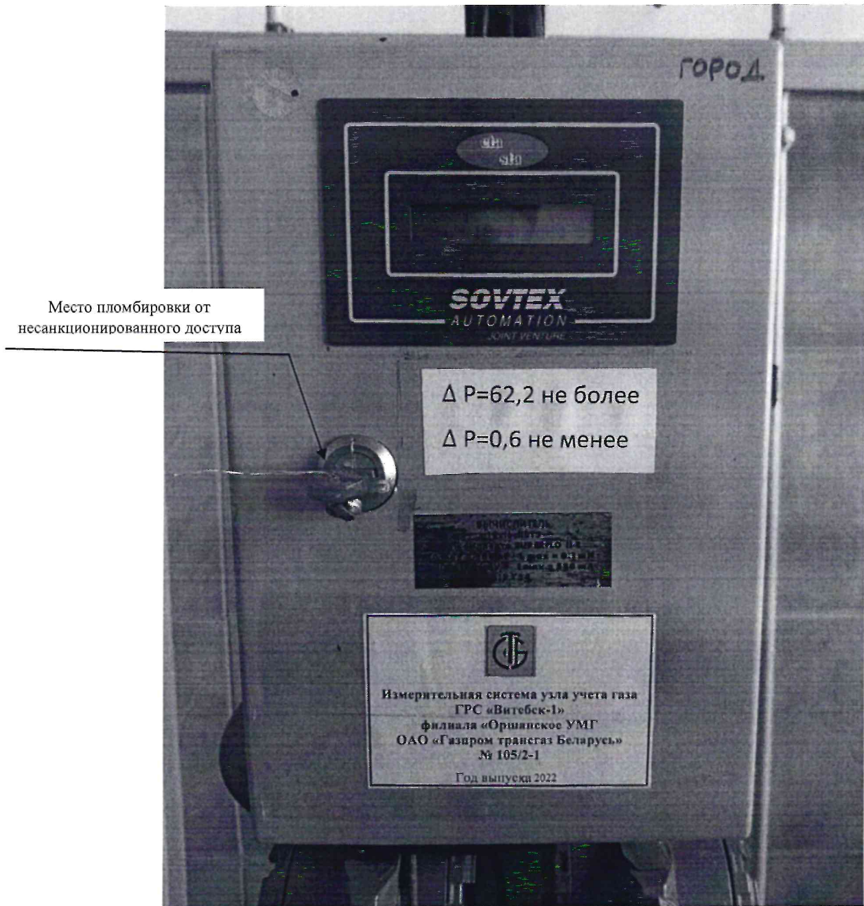
Рисунок 3.1 – Схема пломбировки от несанкционированного доступа
