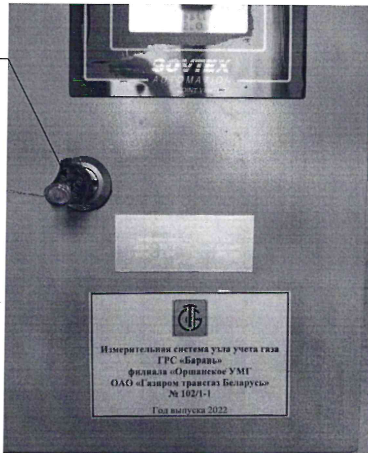
Рисунок 3.1 – Схема пломбировки от несанкционированного доступа
