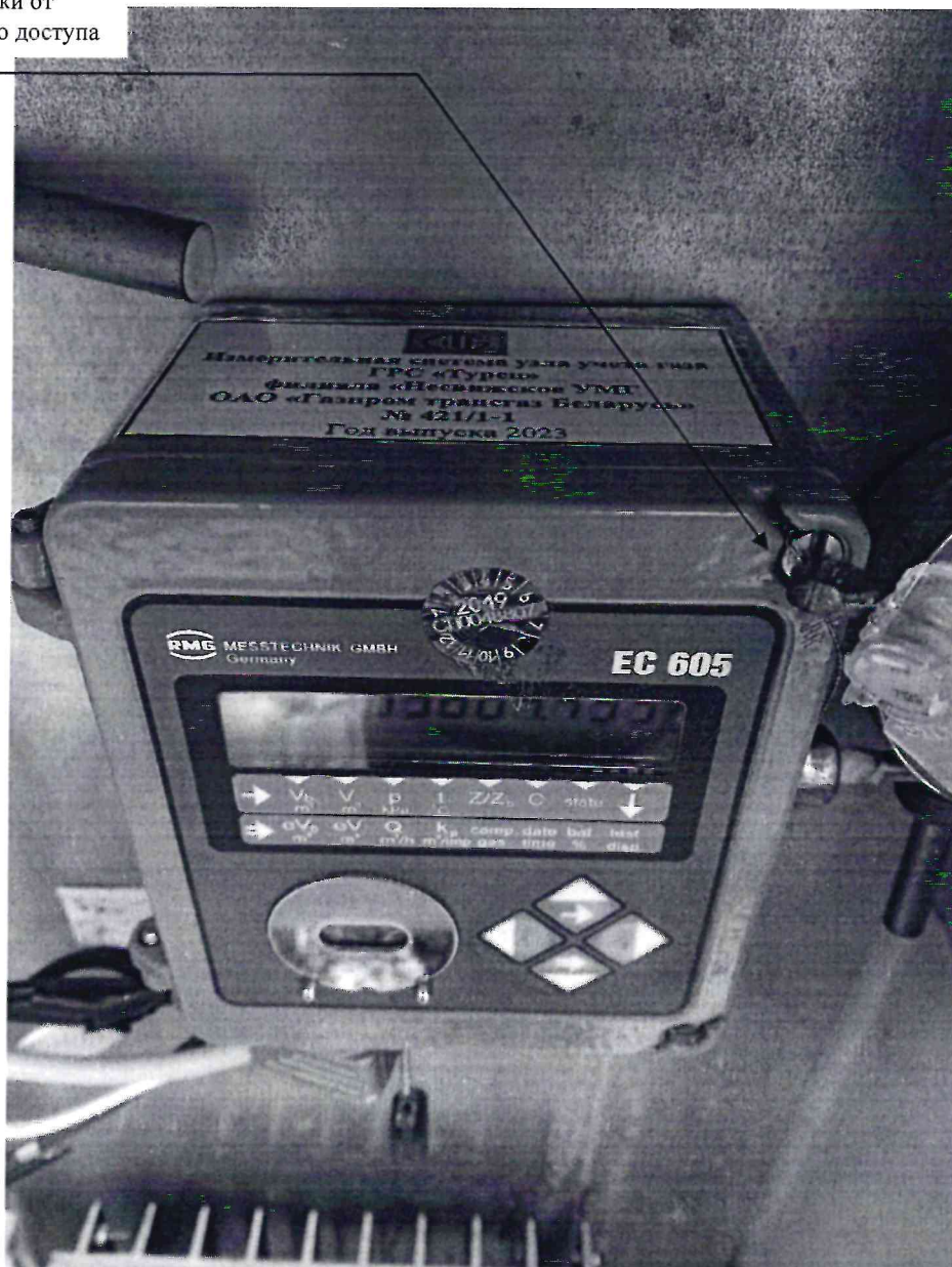
Рисунок 3.1 – Схема пломбировки от несанкционированного доступа
