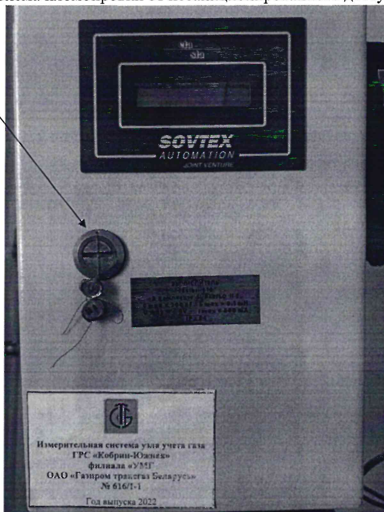
Рисунок 3.1 – Схема пломбировки от несанкционированного доступа
