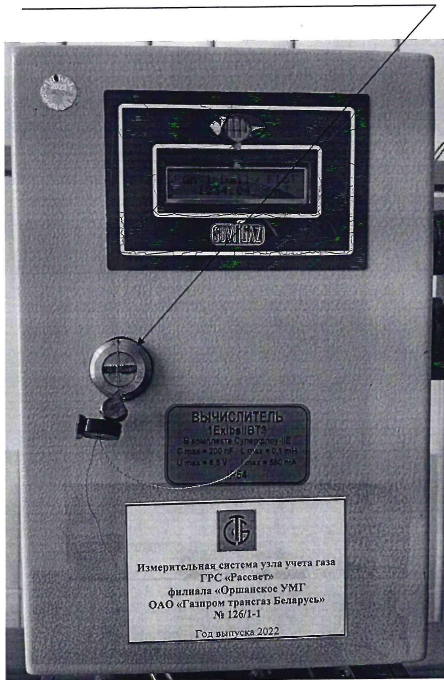
Рисунок 3.1 – Схема пломбировки от несанкционированного доступа
