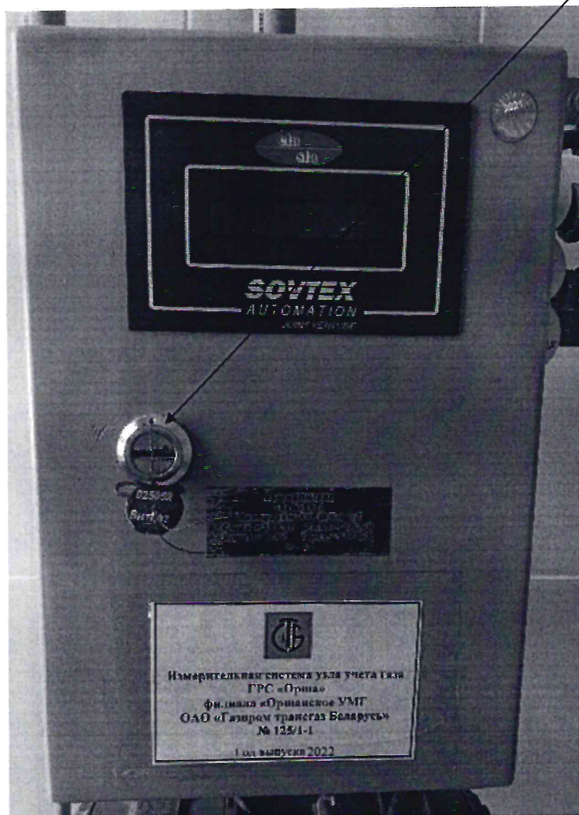
Рисунок 3.1 – Схема пломбировки от несанкционированного доступа
