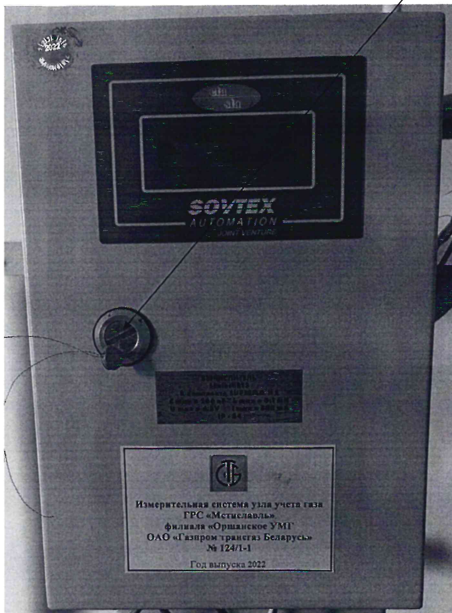
Рисунок 3.1 – Схема пломбировки от несанкционированного доступа
