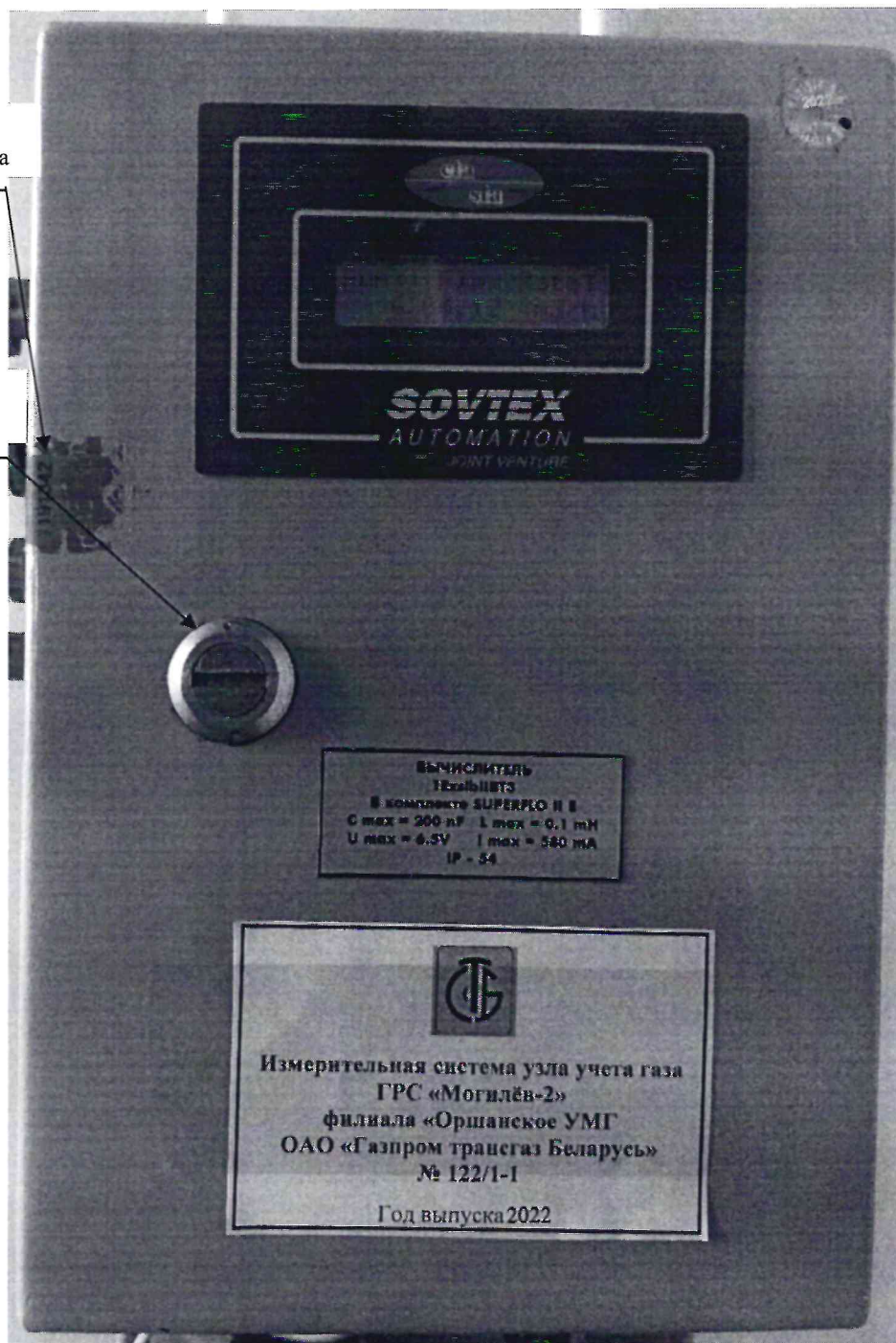
Рисунок 3.1 – Схема пломбировки от несанкционированного доступа
