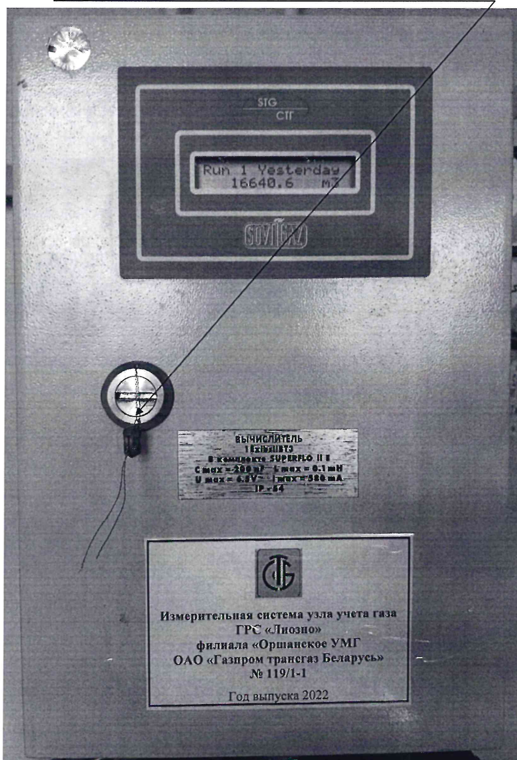
Рисунок 3.1 – Схема пломбировки от несанкционированного доступа
