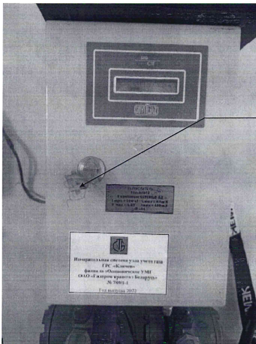
Рисунок 3.1 – Схема пломбировки от несанкционированного доступа
