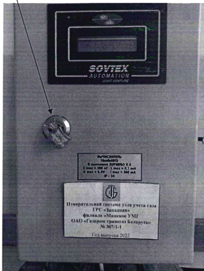
Рисунок 3.1 – Схема пломбировки от несанкционированного доступа
