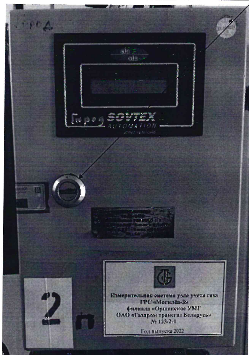
Рисунок 3.1 – Схема пломбировки от несанкционированного доступа
