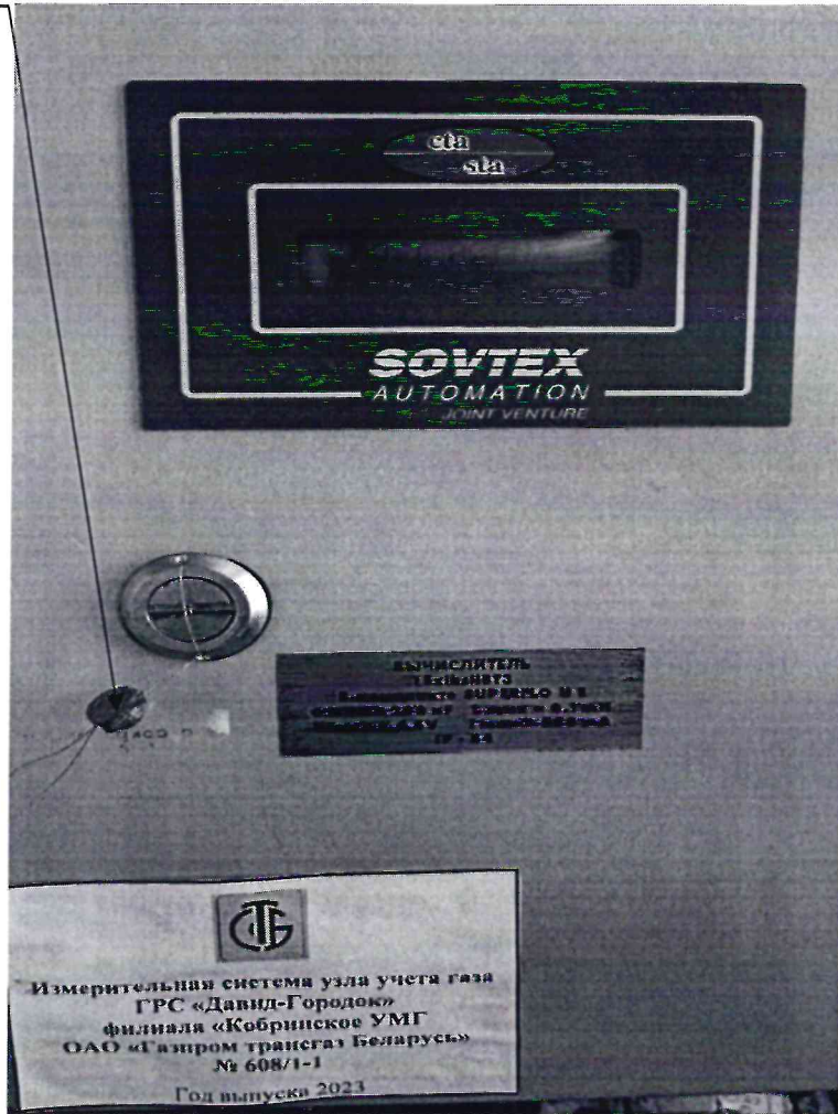
Рисунок 3.1 – Схема пломбировки от несанкционированного доступа
