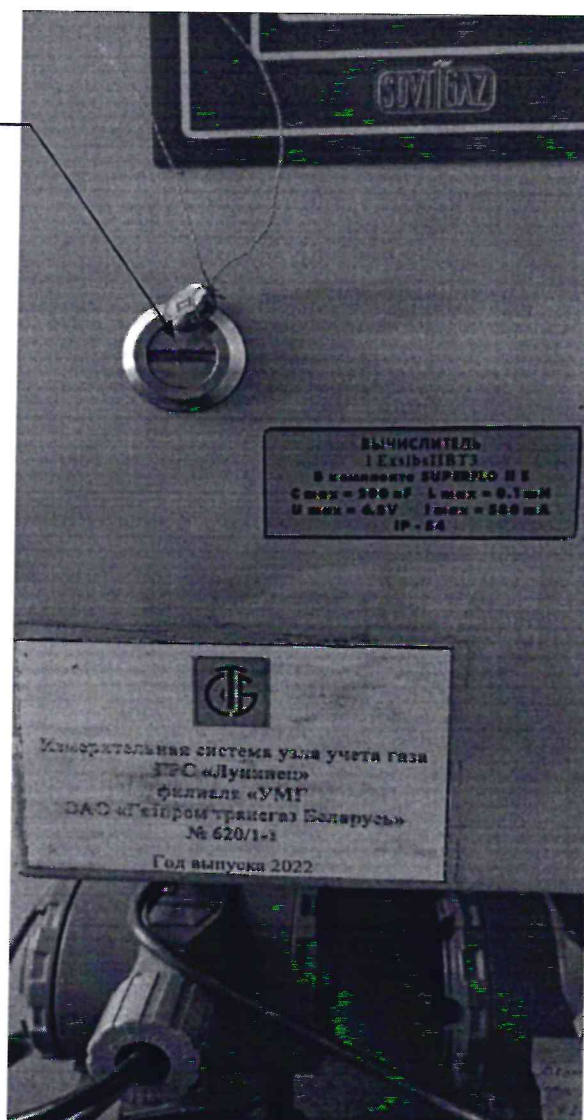
Рисунок 3.1 – Схема пломбировки от несанкционированного доступа
