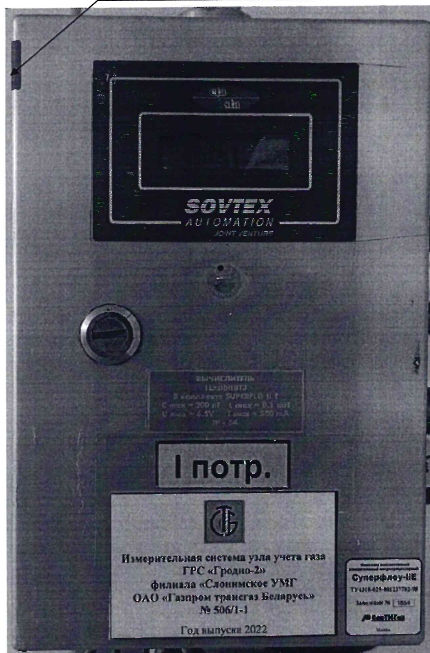
Рисунок 3.1 – Схема пломбировки от несанкционированного доступа
