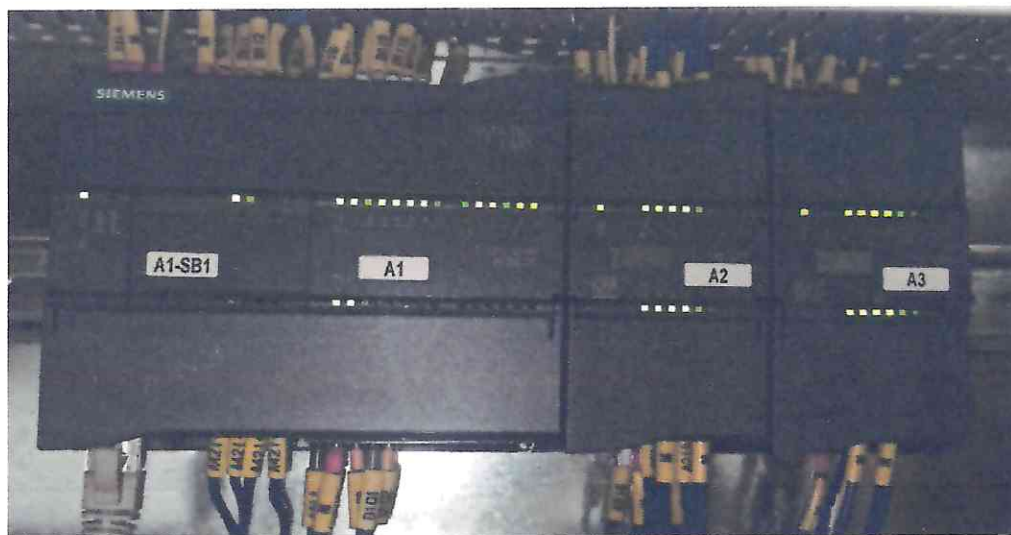
Рисунок 1.5 – Фотография контроллера программируемого SIMATIC S7-1200
