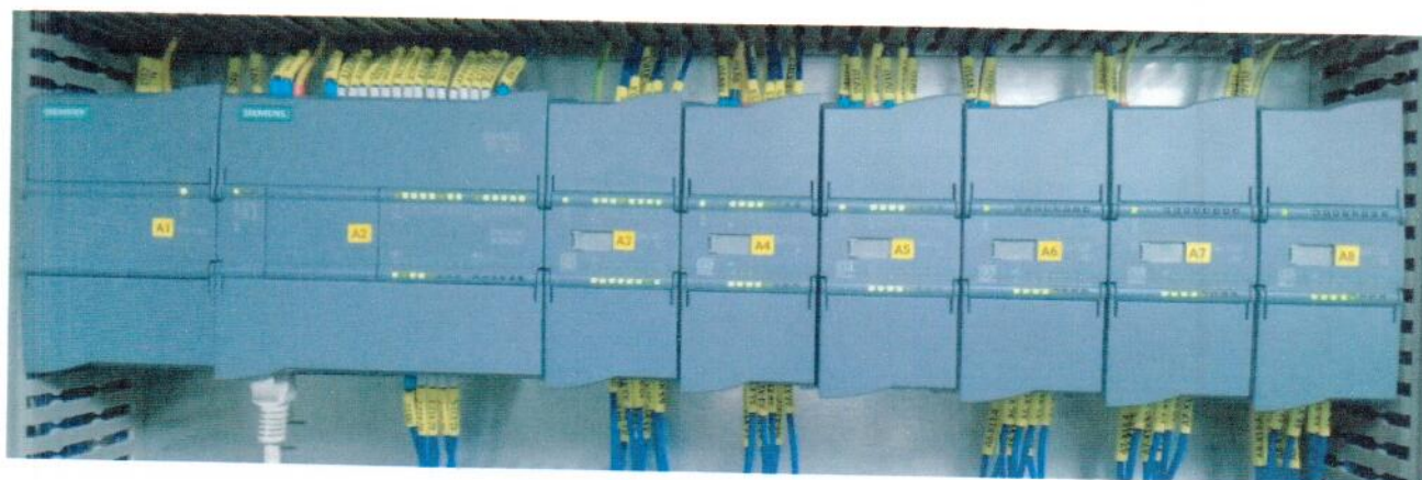
Рисунок 1.6 – Фотография контроллера программируемого SIMATIC S7-1200 с модулями ввода
