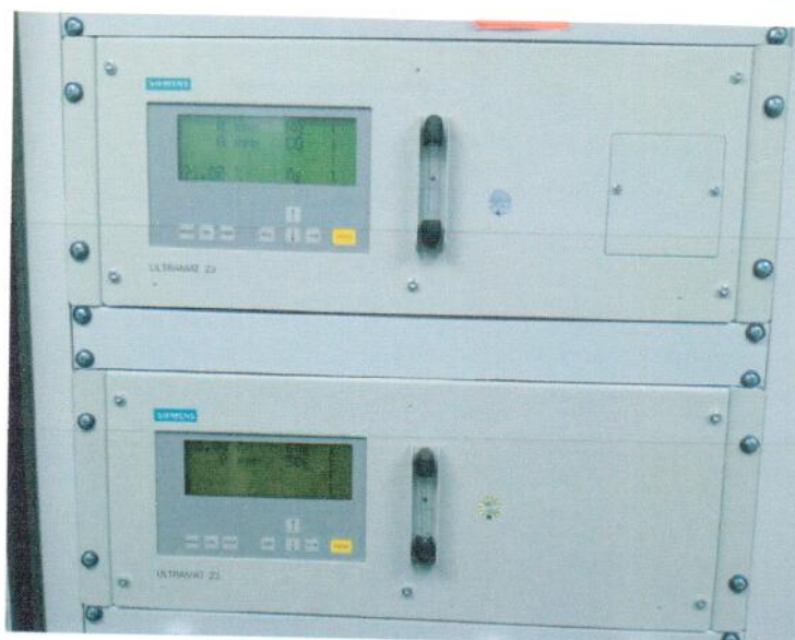
Рисунок 1.1 – Фотография газоанализаторов ULTRAMAT 23
