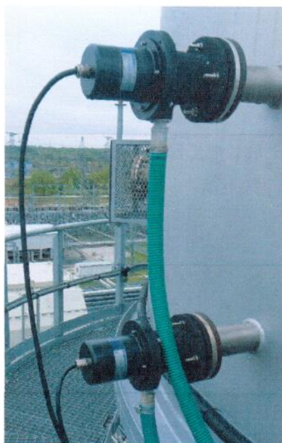
Рисунок 1.5 – Фотография измерителя скорости газовоздушных потоков инфракрасного VCEM 5100
