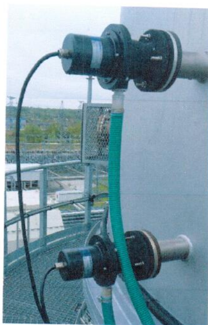
Рисунок 1.5 – Фотография измерителя скорости газовоздушных потоков инфракрасного VCEM 5100
