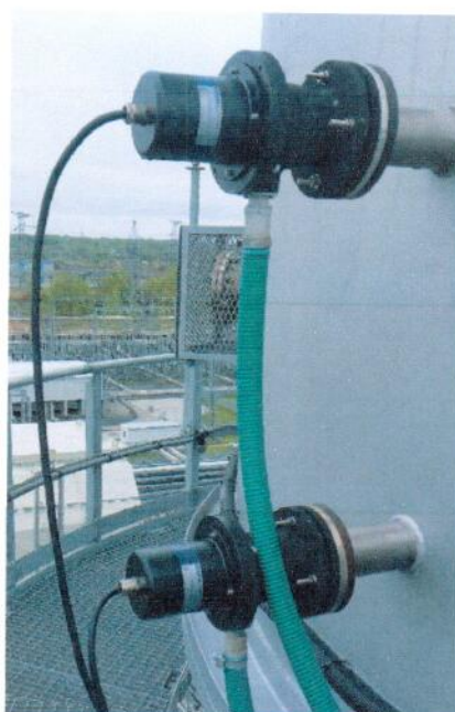
Рисунок 1.5 – Фотография измерителя скорости газовоздушных потоков инфракрасного VCEM 5100
