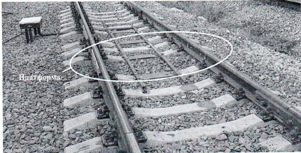
Рисунок 1 – Общий вид ГПУ весов на железобетонных шпалах
