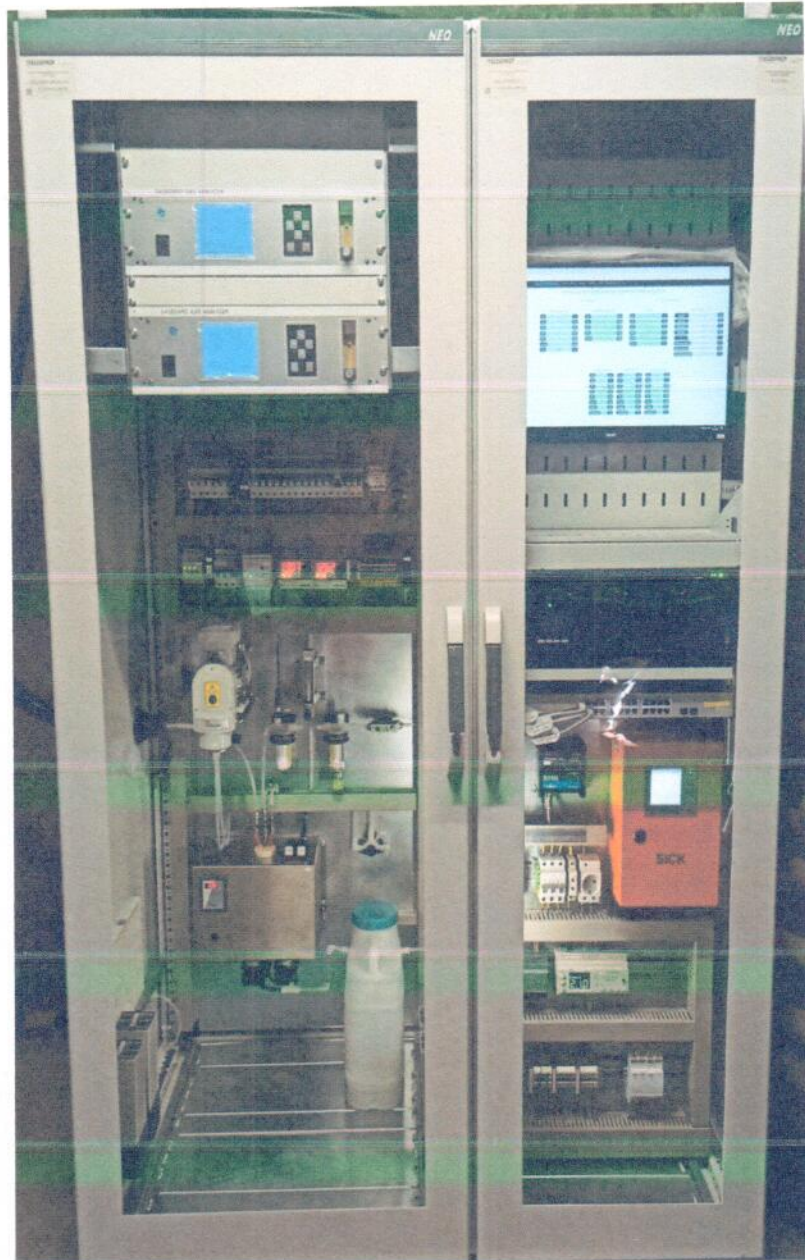
Рисунок 1.9 – Фотография шкафа газового анализа и шкафа серверного
