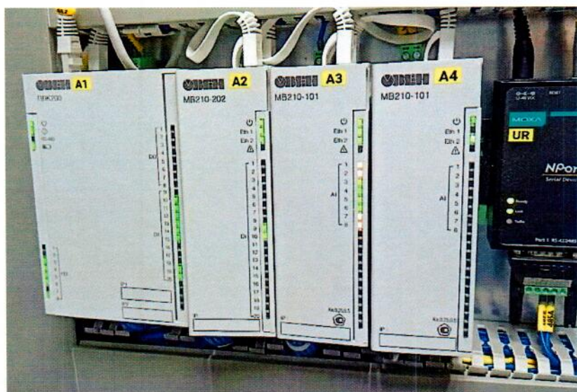
Программируемый логический контроллер ПЛК200-02-CS с модулями ввода MB210-202 и MB210-101
