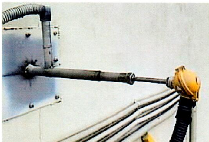
Преобразователь давления измерительный РС-28 и преобразователь температуры СТР-6
