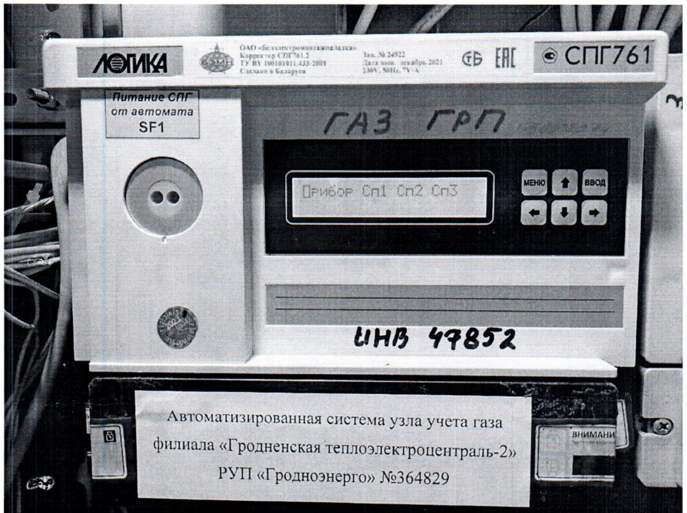
Рисунок 1.3 – Фотография корректора автоматизированной системы узла учета газа филиала «Гродненская теплоэлектростанция-2» РУП «Гродноэнерго» №364829
