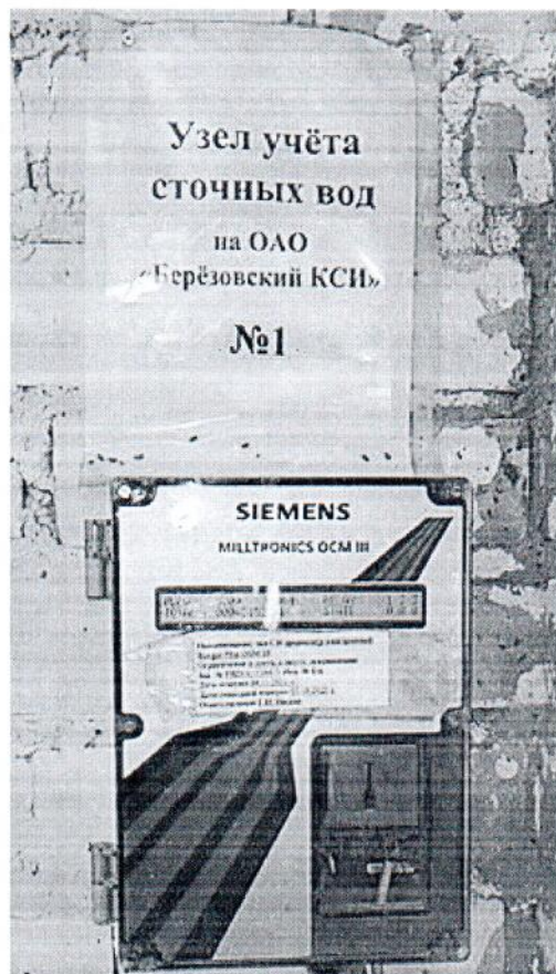
Рисунок 1.8 – Фотография маркировки маркировки узла учета сточных вод на ОАО «Берёзовский КСИ» № 1
