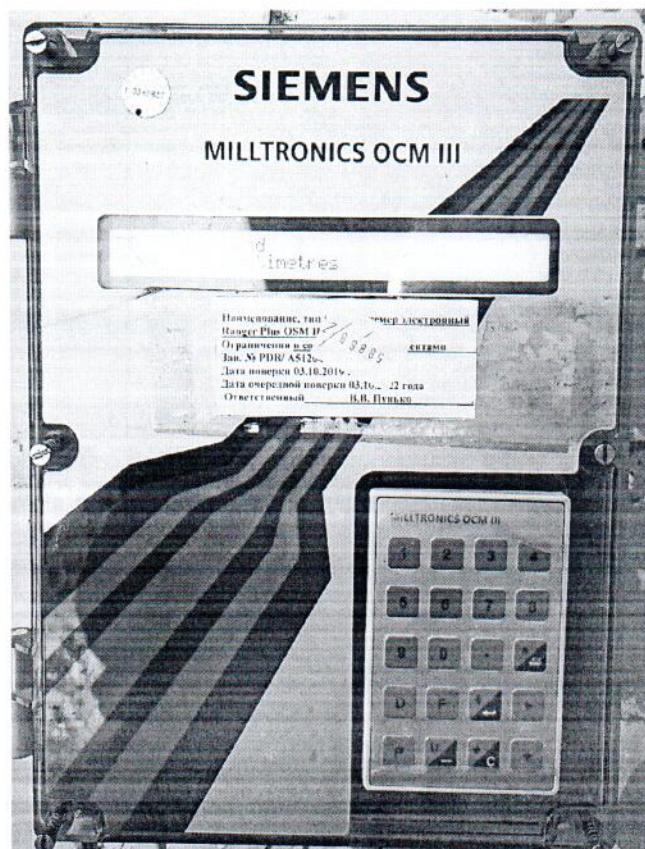
Рисунок 1.1 – Фотография общего вида уровнемера ультразвукового Ranger Plus модификации OCM III № PBD/A5120423 входящего в состав узла учета
